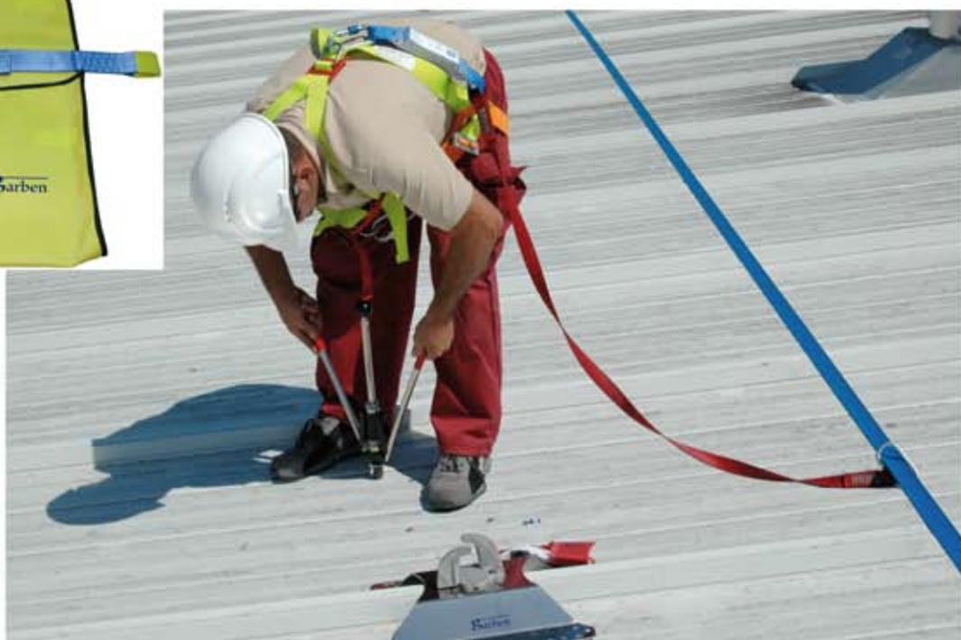
Implantador de línea de anclaje sujeta a LÍNEA C 50
