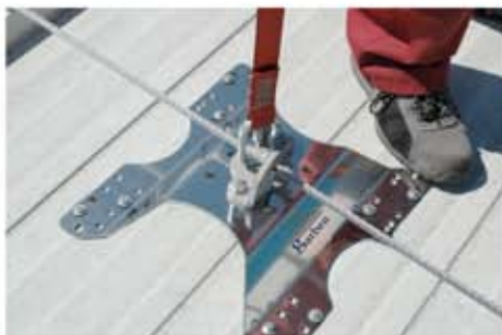
2.- Introducción de mosquetón entre las uñas del anclaje intermedio
