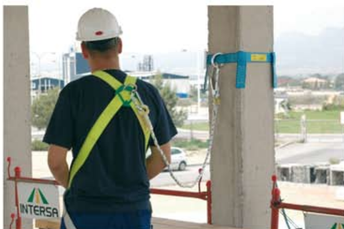
Arnés de seguridad sujeta a dispositivo de anclaje ref. MULTI50 A1
