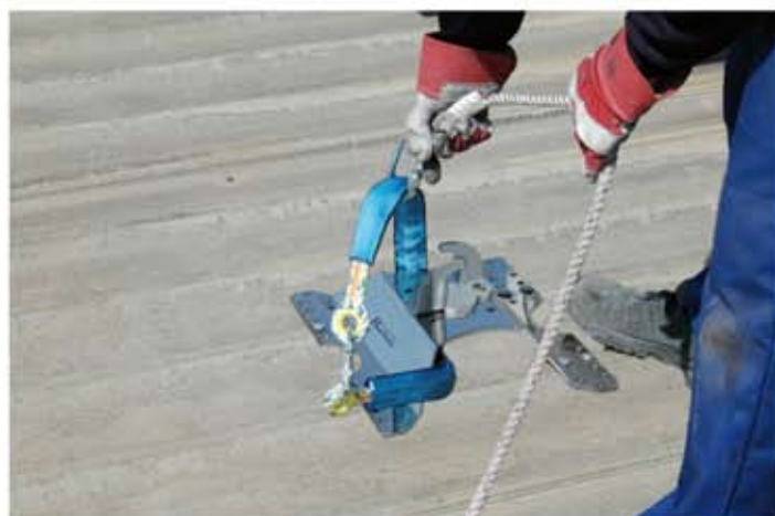
Cuerda con sistema deslizante anticaídas sujeta a eslinga ref. CP10
