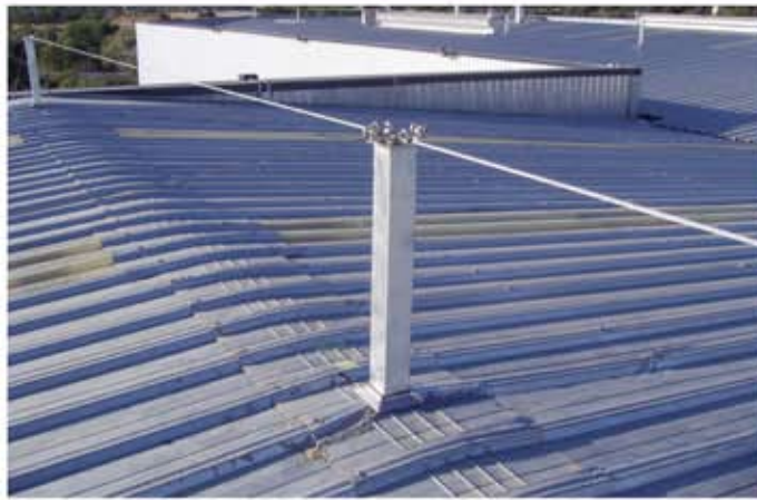
Líneas de anclaje con postes especiales fijados a cerchas por el sistema de abrazadera
