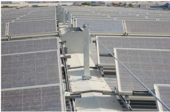
Líneas de anclaje con postes especiales fijados a cerchas por el sistema de abrazadera
