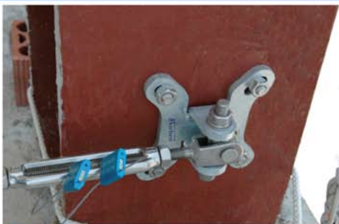
Ref. ONA EX, anclaje extremo fijado a viga de acero
