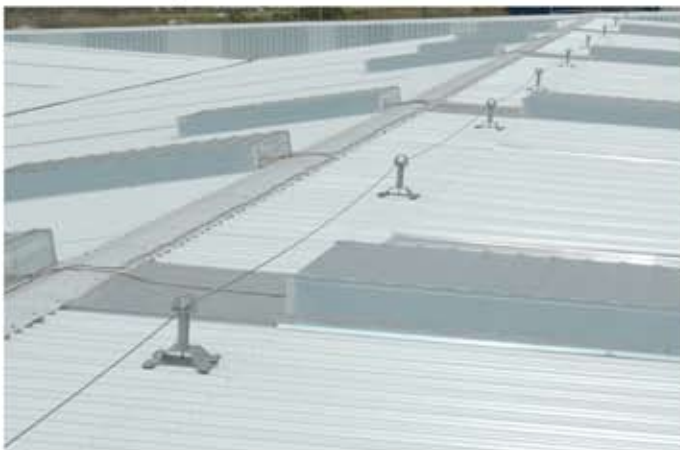
Línea de anclaje fijada a panel tipo sándwich, mediante postes abatibles ref. POSTE 121
