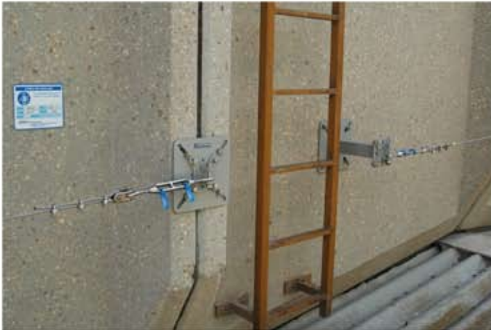
Línea de anclaje fijada a pared con placas / postes especiales para salvar nervios en fachada
