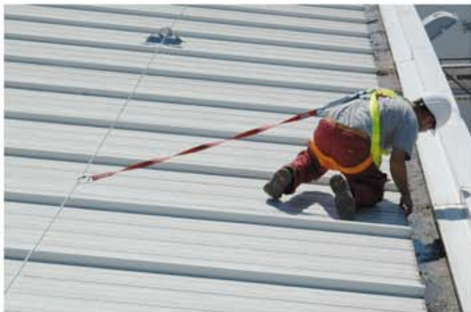
Línea de anclaje: mantenimiento de canalón
