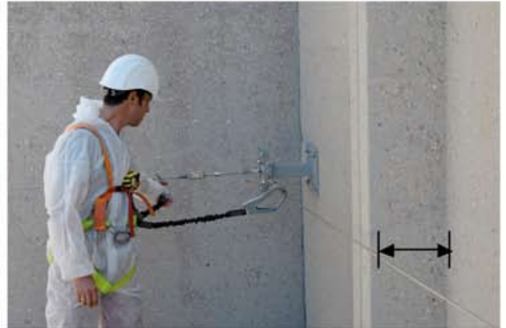
Línea de anclaje fijada a pared con placas / postes especiales para salvar nervios en fachada
